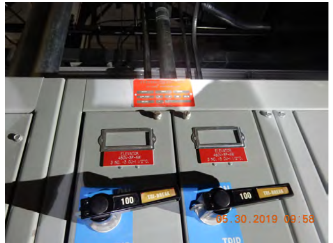
84. Switchgear tag
